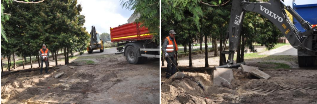
Zdjęcie 5, 6. Prace porządkowe
